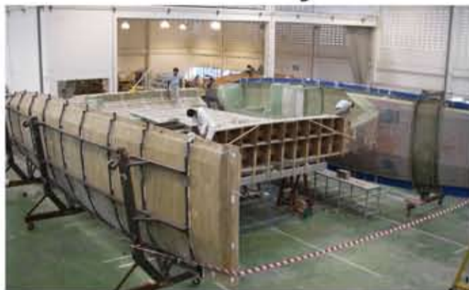
Assemblage des coques et de la nacelle du catamaran Alibi 53
